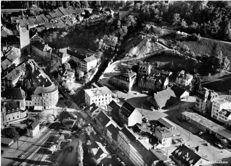
Erste Arbeiten: Wendeplatte für die Strasse auf die Almend.
